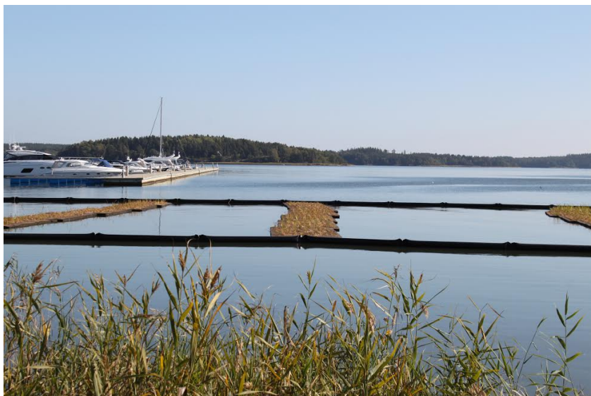
Figur 1. Ett exempel på utformning av skärmbassäng med flytande våtmark i Stora Värtan i Täby kommun. Foto: Mona Kilström
