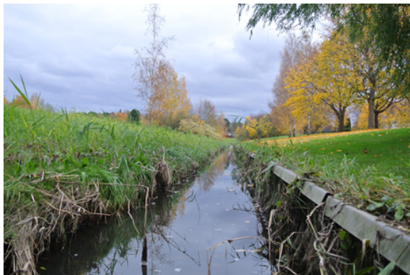
Figur 5. Hamrebacken vid det korrugerade plåtdiket vid Väderlekgatan. Foto: Vilhelm Feltelius
