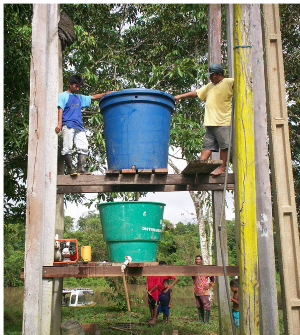
Figur 13. Filtreringsanläggningen i Boyahuasu under uppbyggnad och test
