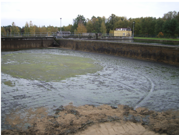
Figur 9. Sandbädd i långsamfilter under rensning.
