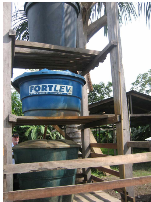
Figur 14. Den färdiga anläggningen i Boyahuasu
