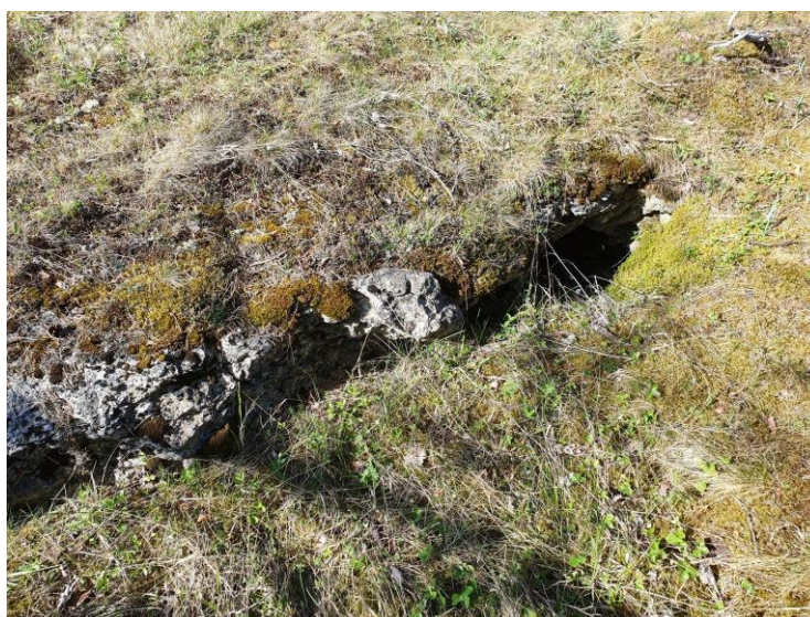
Figur 4. Vattenförande karstsprickor i kalkstensberggrunden. Foto: Bergab.
