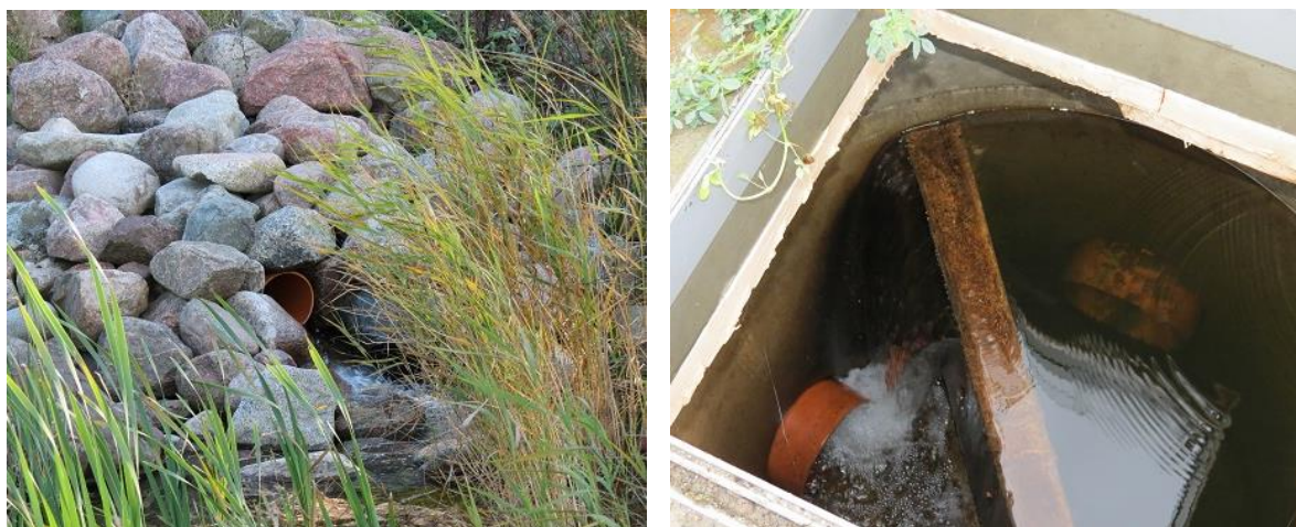
Figur 9. Till vänster: inloppsroret till våtmarken. Till höger: skibordsbrunnen vid utloppet. Foto: Rasmus Elleby 2014-09-29 och 2014-09-04.
