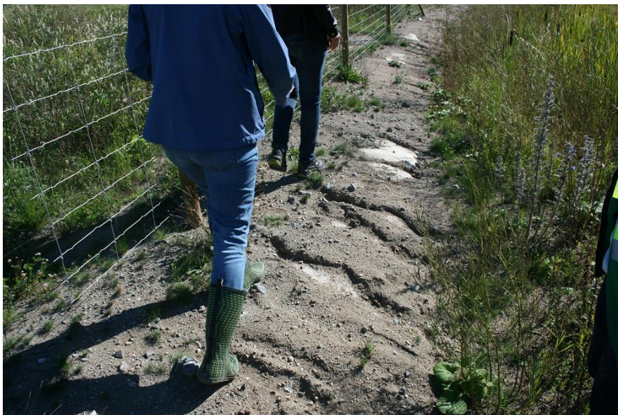
Figur 3. Erosioner av slänten till våtmarken. Foto: Rasmus Elleby 2014-09-04.
