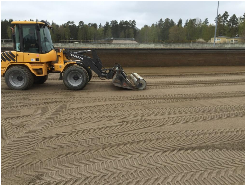
Figur 11. Den mindre hjullastaren under rensningen av filter 4. Notera den för avskrapningsdjupet viktiga vinkeln på skopan. (Foto: M. Mellander)
