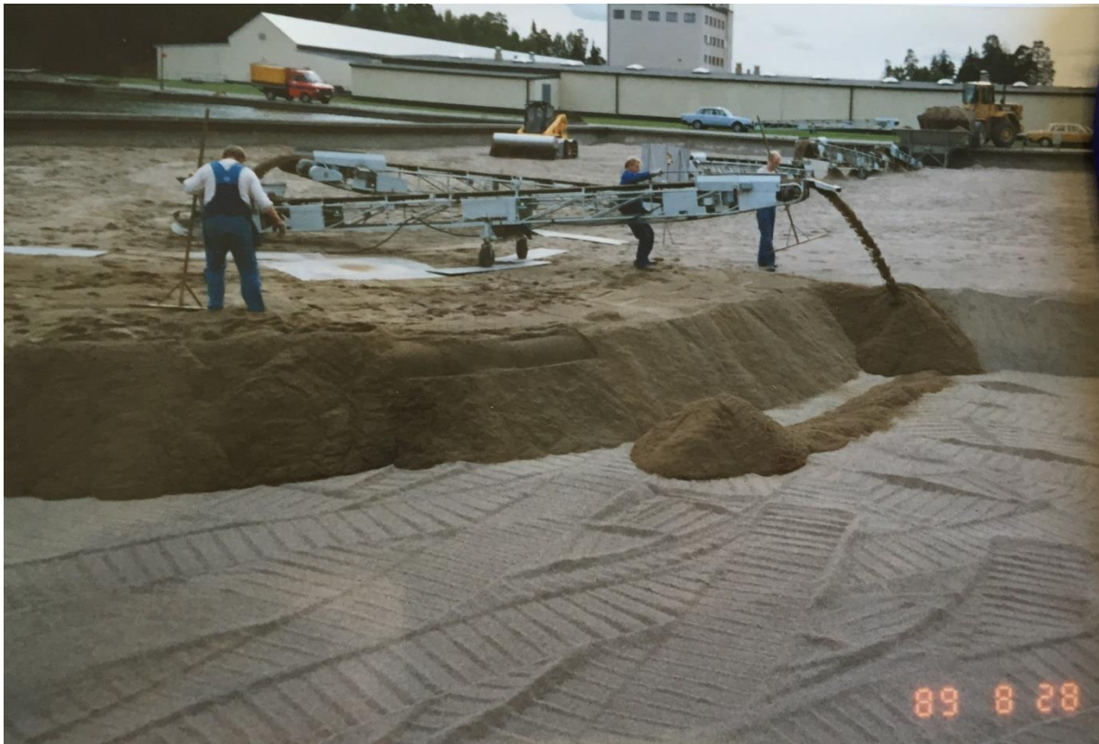
Figur 17. Sandåterfyllnad efter djuprensning år 1989. Foto tillhandahållet av Börje Larsson vid Stockholm Vatten.
