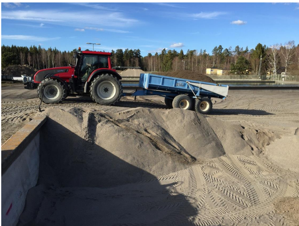
Figur 15. Sand transporteras ned i filtret med hjälp av sandrampen. (Foto: M. Mellander)
