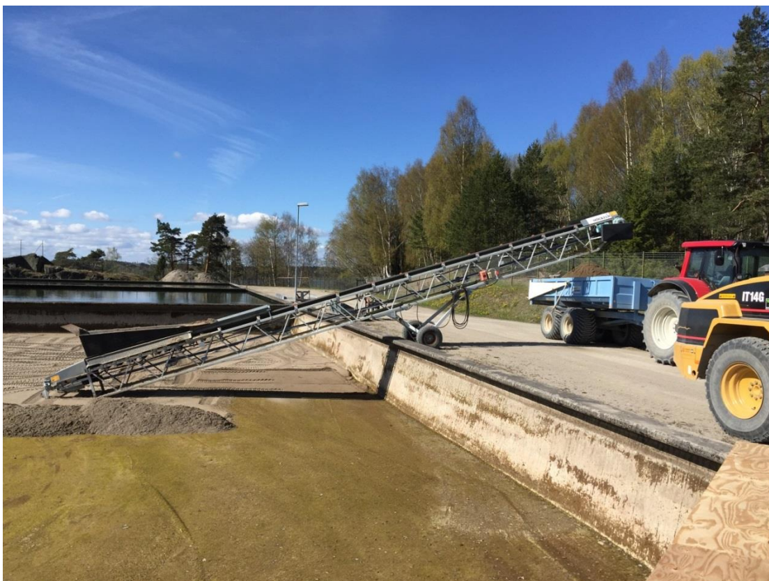
Figur 12. Transport av avskrapad sand med hjälp av transportband. (Foto: M. Mellander)
