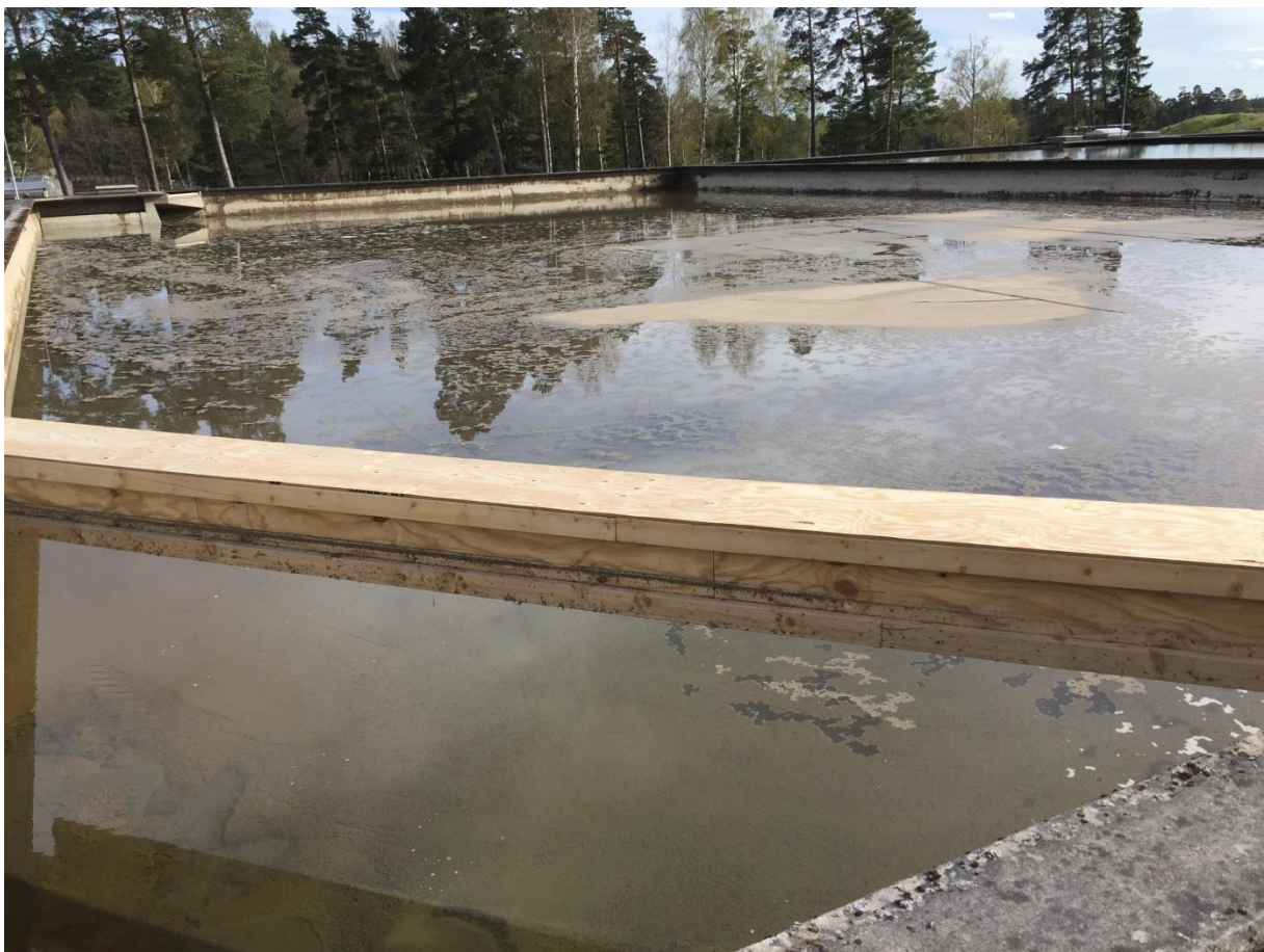
Figur 76. Filter 14 under återfyllnad, där en "torr ö" ses i filtrets mitt. (Foto: M. Mellander)
