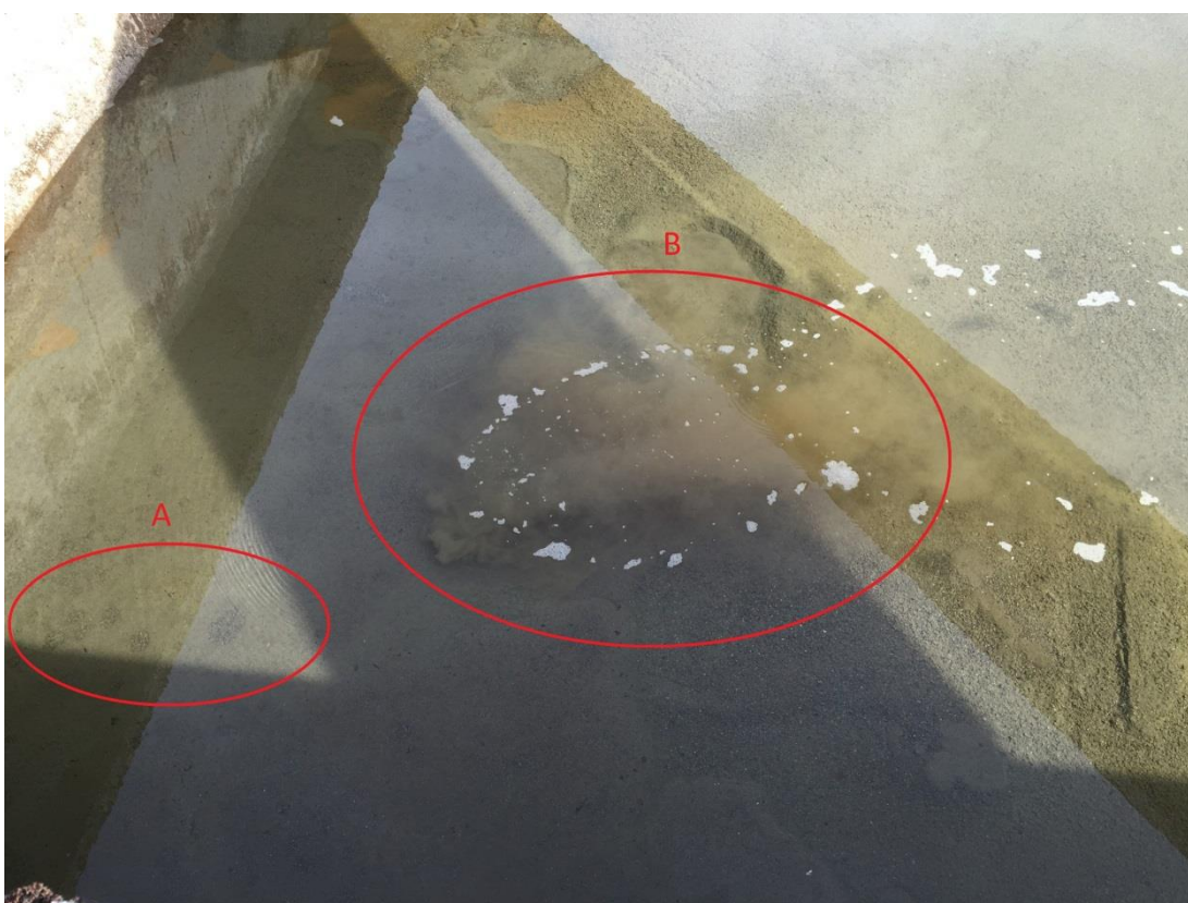
Figur 78. I cirkel A ses kokande sandrörelse och i cirkel B ses fina sandpartiklar sprutas upp ur filterbädden. (Foto: M. Mellander)
