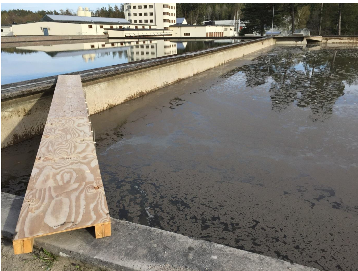
Figur 79. Sand på vattenytan vid fyllning av filter 14. (Foto: M. Mellander)
