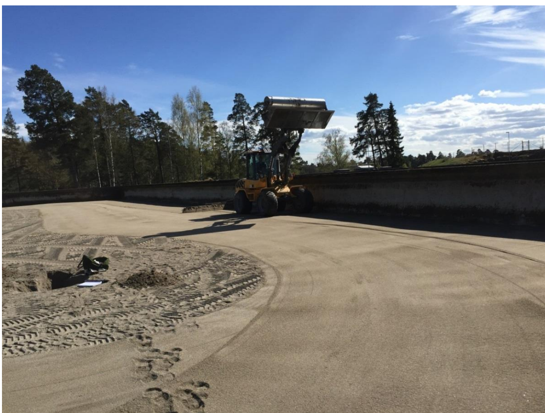
Figur 13. Filterbädden jämnas till sedan hela ytan skrapats av. Till vänster ses en av provgroparna som grävdes för provtagning. (Foto: M. Mellander)
