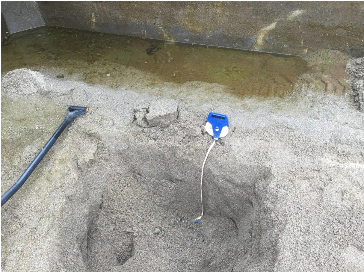
Figur 68. Gropen som grävdes invid det stående vattnet vid inloppet till filter 4. Observera att inga prover togs i denna grop. (Foto: M. Mellander)
