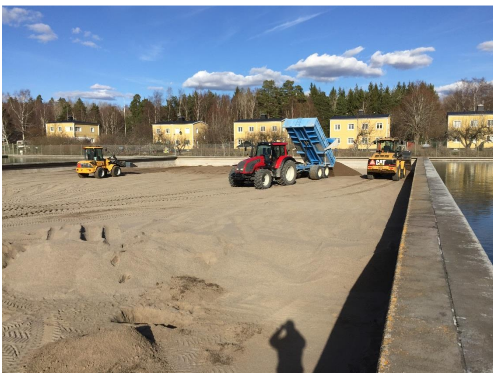
Figur 16. Den större hjullastaren och traktorn med släp lämnar sand (till höger) medan den mindre hjullastaren jämnar ut sanden (till vänster). (Foto: M. Mellander)
