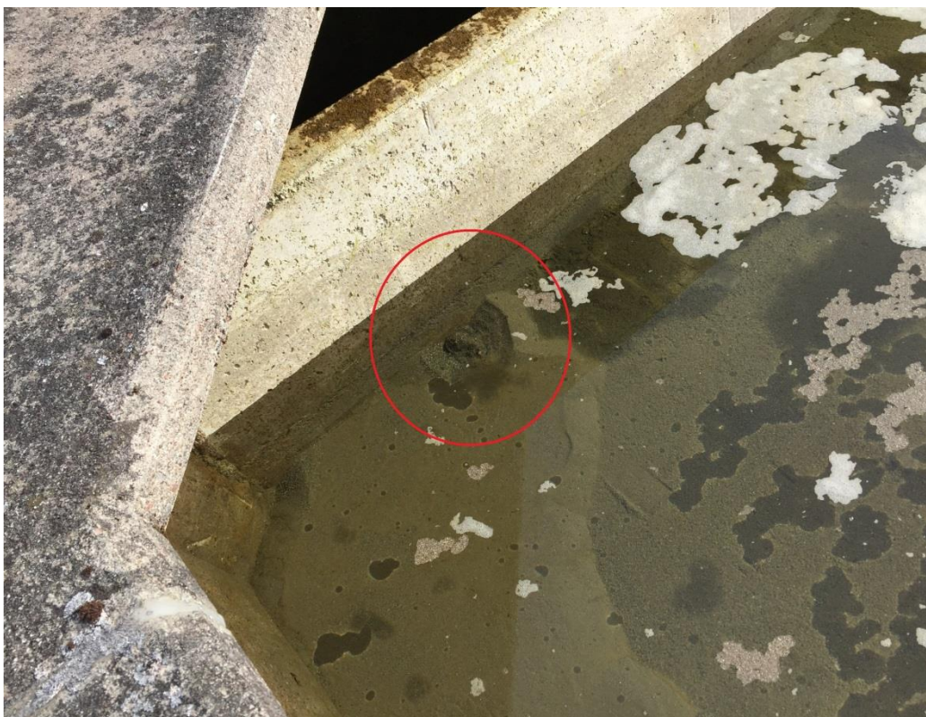
Figur 77. Exempel den på kokande sandrörelse som observerades, där en tydlig bubblande rörelse är markerad med röd ring. (Foto: M. Mellander)
