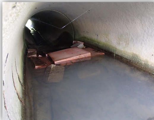
Figur 15b. Vattnet rann över dämningen och endast toppen på betongplattorna ovanpå filtret är synligt. Mycket svårjobb vid installationen på grund av det höga vattenflödet.
