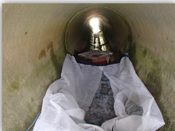
Figur 14. Filteromslutaren av geotextil på botten av trumman just innan vatten flödade över dämningsskivan.
