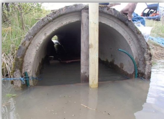
Figur 15a. Inloppet sett utifrån. Stolpen förankrar filtret och plankan säkrar dämningen. Hög vattenföring gör att dikesvatten strömmar ovanpå filtret.
