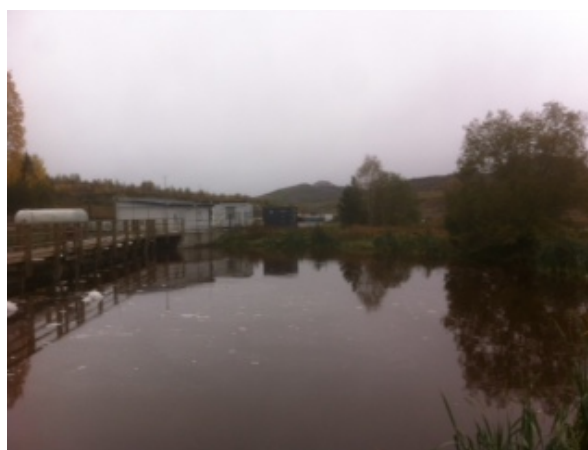
Figur 12. Denitrifikationsbassängen, L2B. Foto: Liselott Karlsson
