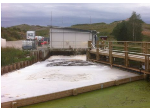
Figur 13. Efterluftningsbassängen, L2C, samt pumphuset för utgående vatten. Foto: Liselott Karlsson
