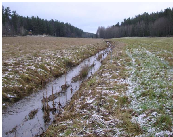
Figur 5. Diket som avleder vatten från Löt avfallsanläggning till recipienten. © SÖRAB 2008
