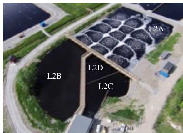
Figur 10. KBR-anläggningen med de olika reningsstegen markerade (L2A–L2D). © SÖRAB 2014
