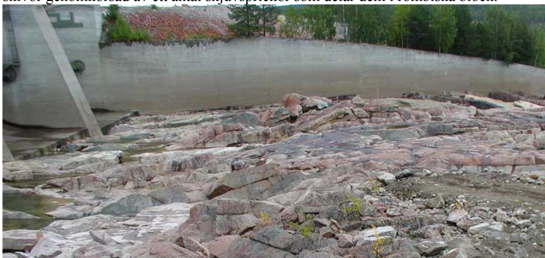
Figur 6.5 Nedströms utskoven är bergmassan högre än skiborden.
