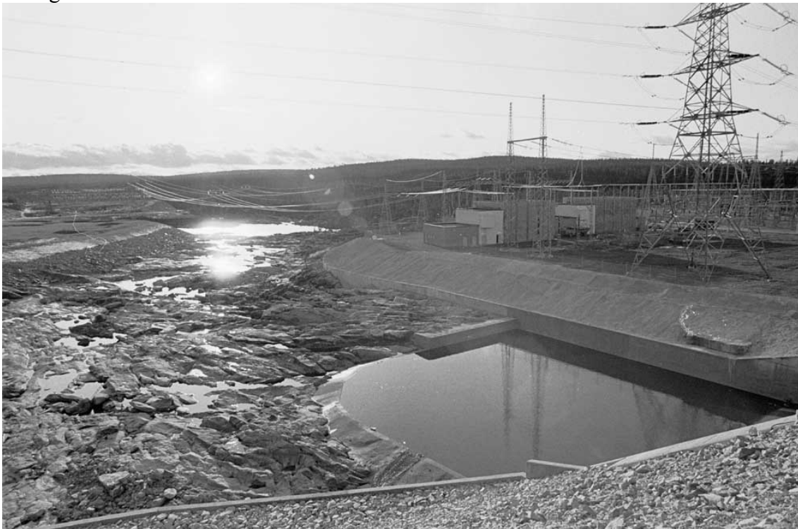
Figur 6.9 Fotografi över Porjus utskovskanal från 1980. Högra delen av kanalen närmast energiomvandlargropen ser högre ut än idag.
