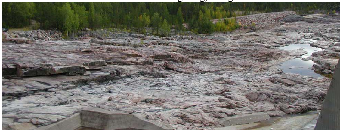
Figur 6.6 Liggas kanal nedströms utskovet. Bergmassan på vänstra sidan av kanalen är skivigare och högre.
