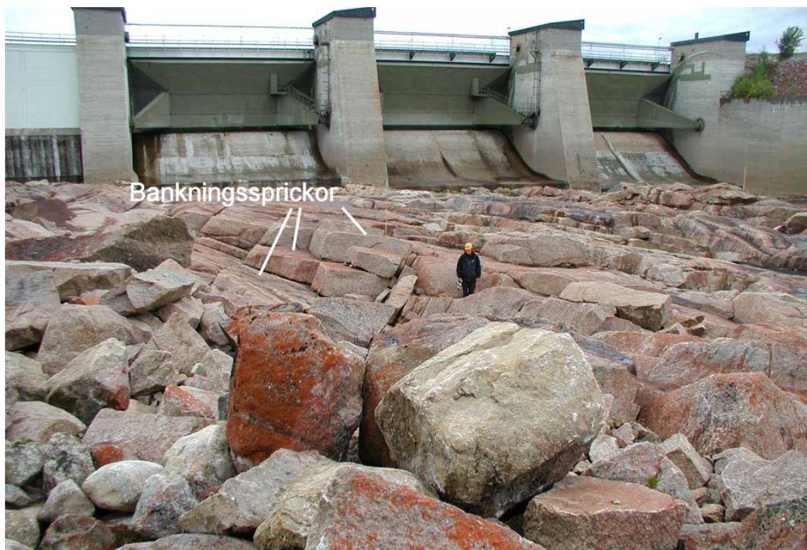
Figur 6.4 Nedströms utskoven i Harsprånget. De markerade subhorisontella sprickorna blir tätare mot vänstra kanten.
