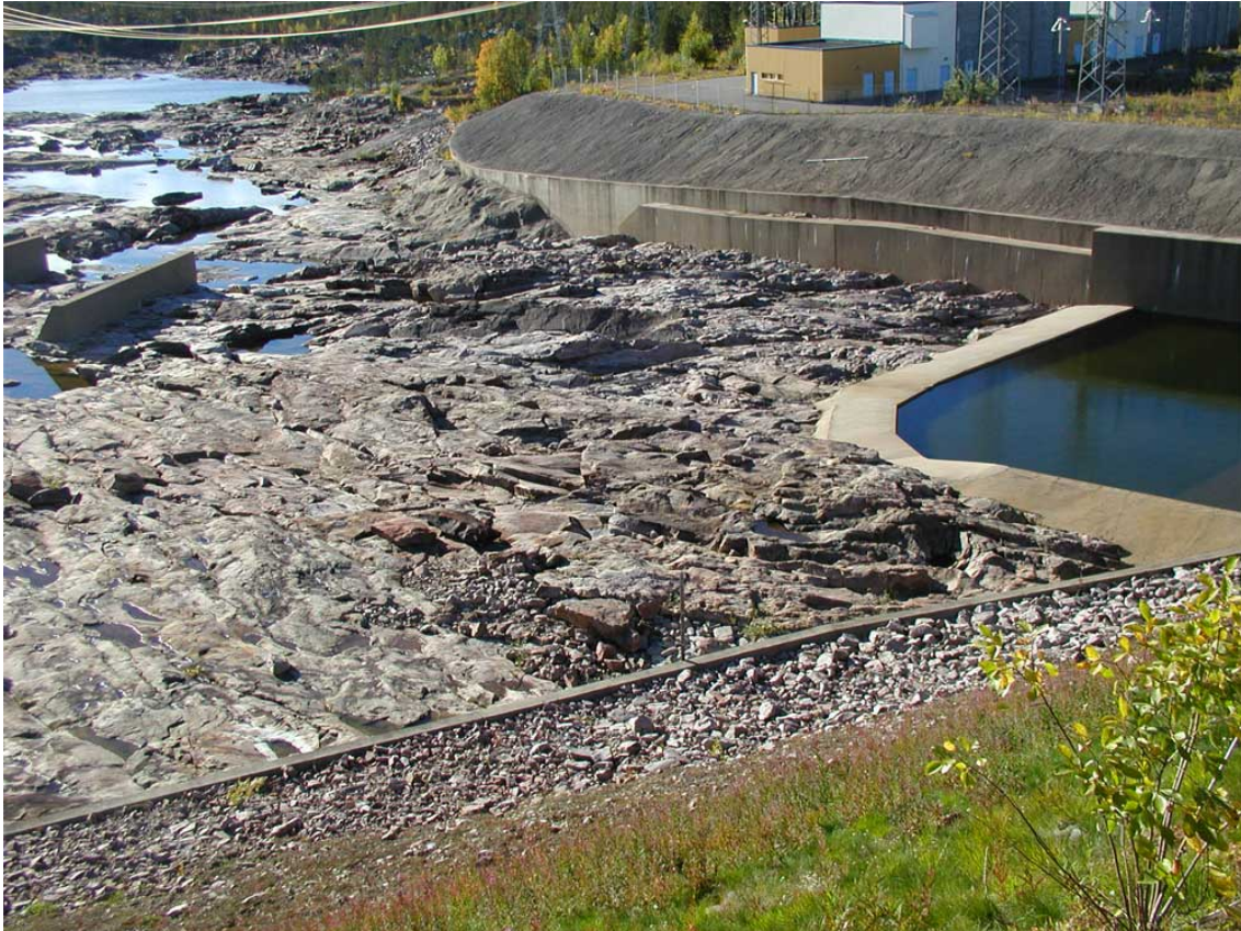
Figur 6.10 Fotografi över Porjus utskovskanal från 2004. Området närmast energiomvandlargropen verkar vara något förändrad jämfört med 1980.
