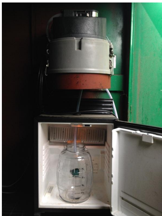
Figur 9. Provtagarutrustning för flödesproportionell provtagning av Kungsängsdammen. Foto: Jonathan Arnlund
