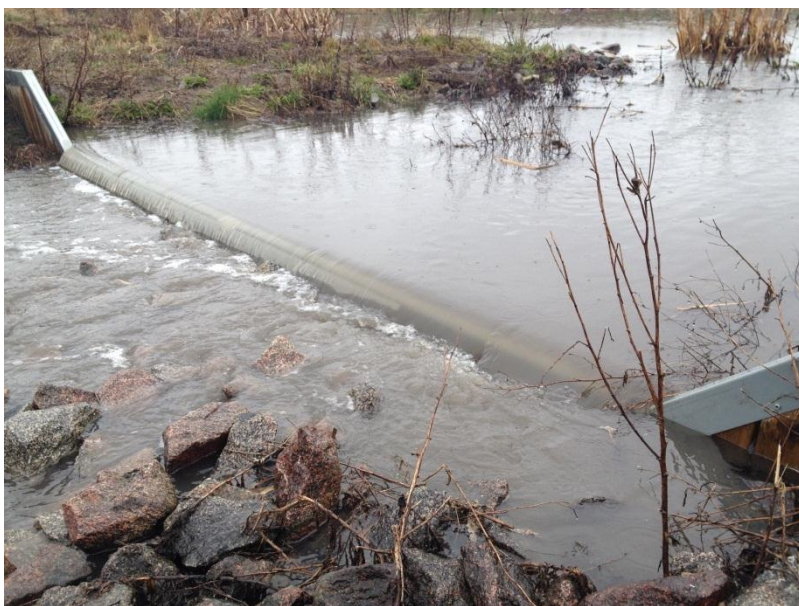
Figur 16. Högt flöde vid bräddningen innan inloppet till Kungsängsdammen den 7 april 2014. Vid fototillfället ökade nivån i dammen med 8,5 cm på ett halvt dygn. Foto: Jonathan Arnlund.
