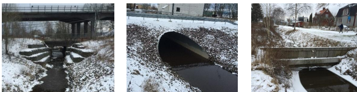
Figur 5. Vänster till höger: Begränsande sektionerna järnvägsbron över stambanan, rörbron under Kvarngatan och regleringsvallen i Rösättersbäcken vid överledningsdiket
