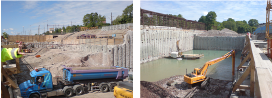
Figur A.1. Sekantpåleväggar vid Grop G, Norra Länken NL 12. Bilderna är tagna den 26 maj 2008.
