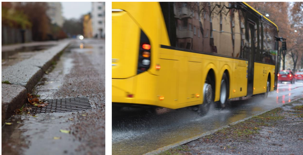
Figur 1. En dagvattenbrunn (t.v.) samt dagvatten på vägytor (t.h.) i Uppsala, december 2015. Foto: Johan Karlsson.
