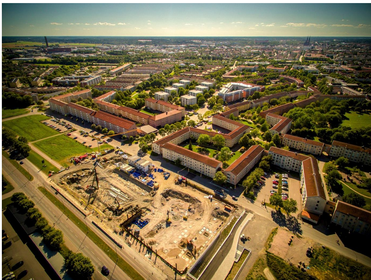
Figur 8. Flygbild över nyexploatering i området Sala backe. Ett tidigare kraftledningsstråk mellan Fyrislundsgatan och Johannesbäcksgatan utnyttjas för bostadsbyggande. Foto taget i sydvästlig riktning där Gröna gatan kommer ut vid exploateringsområdets sydvästra hörn. Bildnamn: "Gröna gatan/Sala backe". Foto: Janne Jansson.
