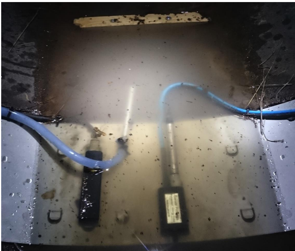
Figur 13. Placering av fördämning i norra provtagningspunkten. En 45 mm hög bräda fästes (högst upp i bild) i dagvattenledningens botten nedströms (från vänster till höger) den primära flödesmätaren, insugningsslangen och den sekundära flödesmätaren för att säkerställa att dessa tre alltid befann sig under vattenytan. Foto: Johan Karlsson.
