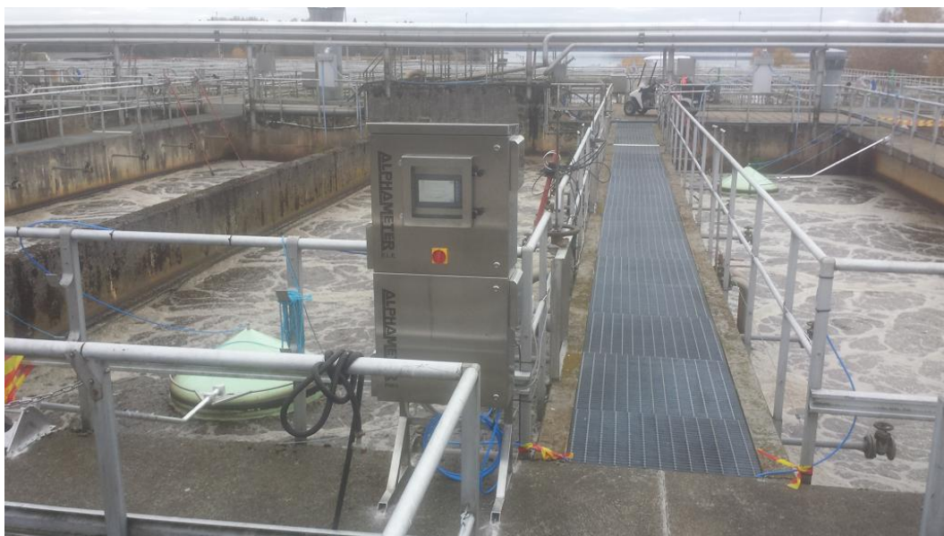
Figur 13. Alphametern och båda huvarna i zon 2 och zon 6 installerade i linje 7 på Himmerfjärdsverket, Syvab.
