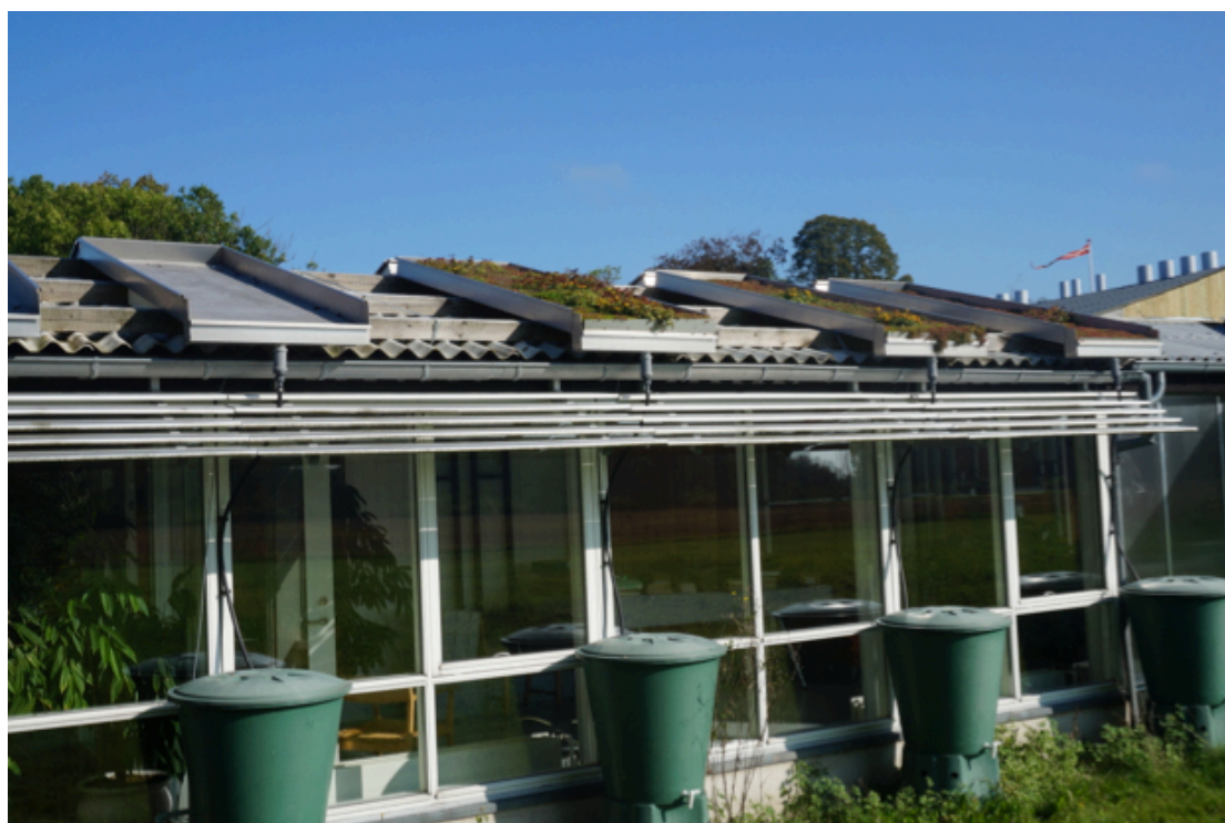
Figur 4 Takbehållare i sydlig riktning med behållare för uppsamling av avrinningsvatten. Referenstak beläget till vänster i bild och de tre modellerna av gröna tak till höger i bild (Foto: Jenny Andersson, 2014).
