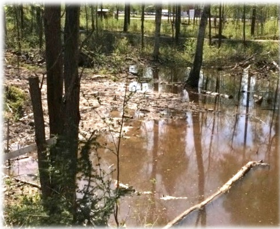
Figur 2. Översvämning i Grycksbo på grund av tätade ledningar. Publicerad med tillåtelse av Lundgren 5 .
