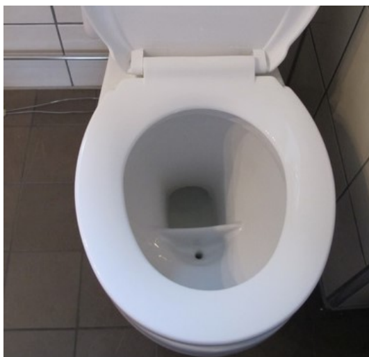
Figur 1: Ett fotografi som visar en urinsortande toalett. I toaletten kan två olika utlopp ses, ett mindre för urinen och ett större avsett för fekalier och toalettpapper.
