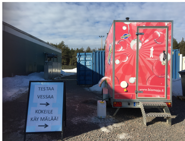
Figur 14: Ett fotografi som visar Biomajan färdig för användning i Säkylä. Till vänster om Biomajan ses ett uppsamlingskärl för överflöde. Längre bak ses avfuktarens utloppsrör genom Biomajans vägg.
