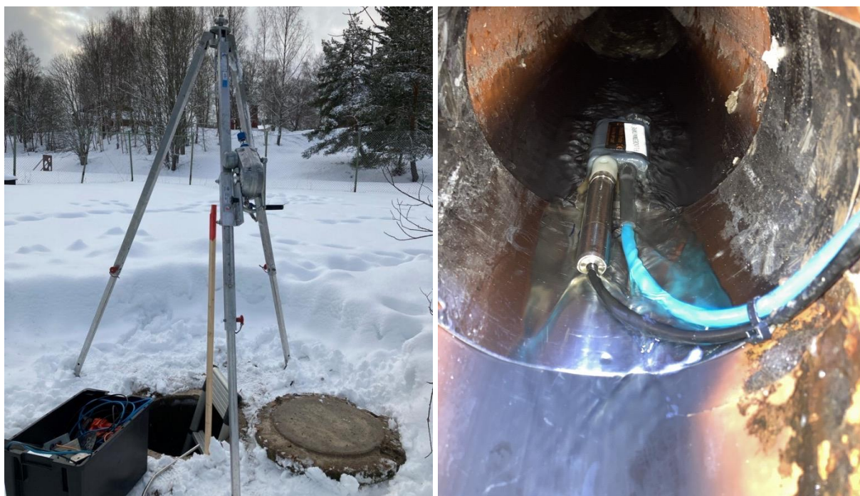
Figur 6 & 7: Figur 6 illustrerar uppställningen av tripoden ovanför den brunn där en flödesmätare monterades. Figur 7 är en bild på flödesmätaren av modell Mainstream TM efter montering i ledningen, riktad mot flödet.
