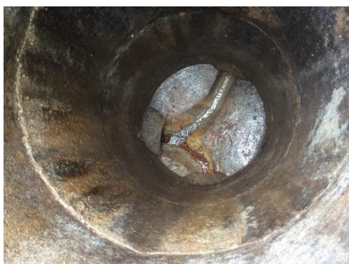
Figur 11. Brunn med avloppsvatten från industrin och ett hushåll. Nederst i bilden ses utloppet från industrin, längst upp i bilden syns avloppet från ett hushåll. Dessa förenas i avloppsledningen som syns till vänster i bilden. Foto: Amanda Haglind.
