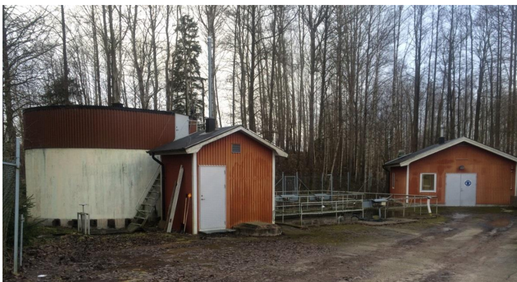
Figur 4. Älgarsås avloppsreningsverk. Biobädden syns till vänster i bilden. Foto: Amanda Haglind.
