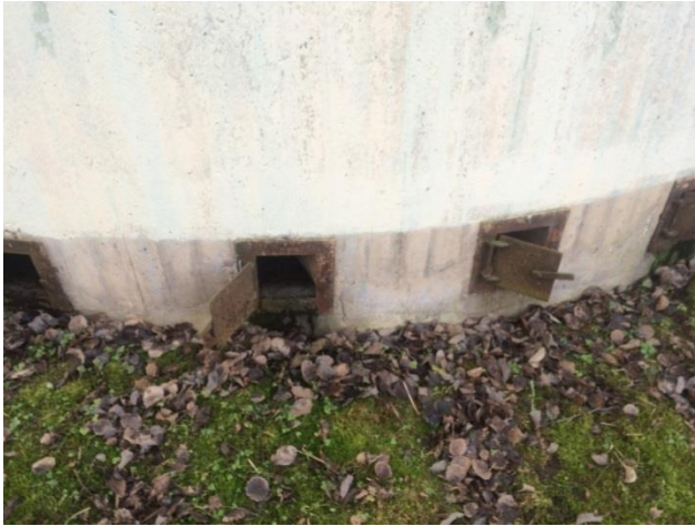
Figur 9. Botten på biobädden, med luftningsluckor. Foto: Amanda Haglind.
