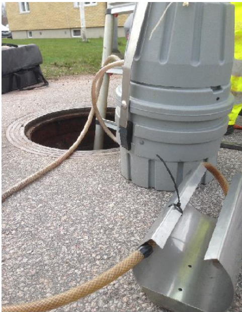
Figur 12. Mätanordning, med cylinder och inbyggt dämme. I bakgrunden syns provtagaren. Foto: Amanda Haglind.
