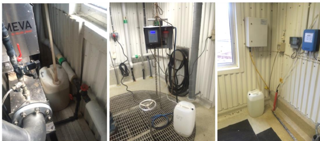
Figur 6. Provtagningen av inkommande vatten, vatten som pumpas till biobädden och utgående vatten. Foto: Amanda Haglind.
